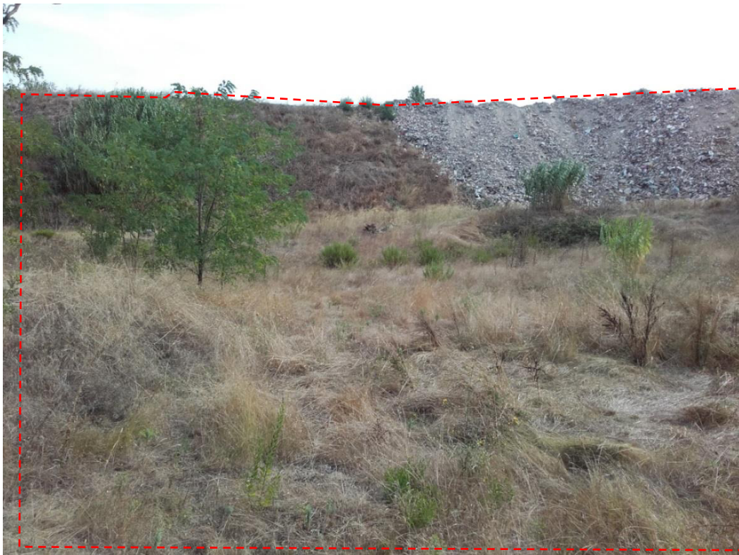
Photographie 1 : Etat actuel du sol au droit du casier n°2 (en fond le talus du casier n°1 servant appui au casier n°2)
