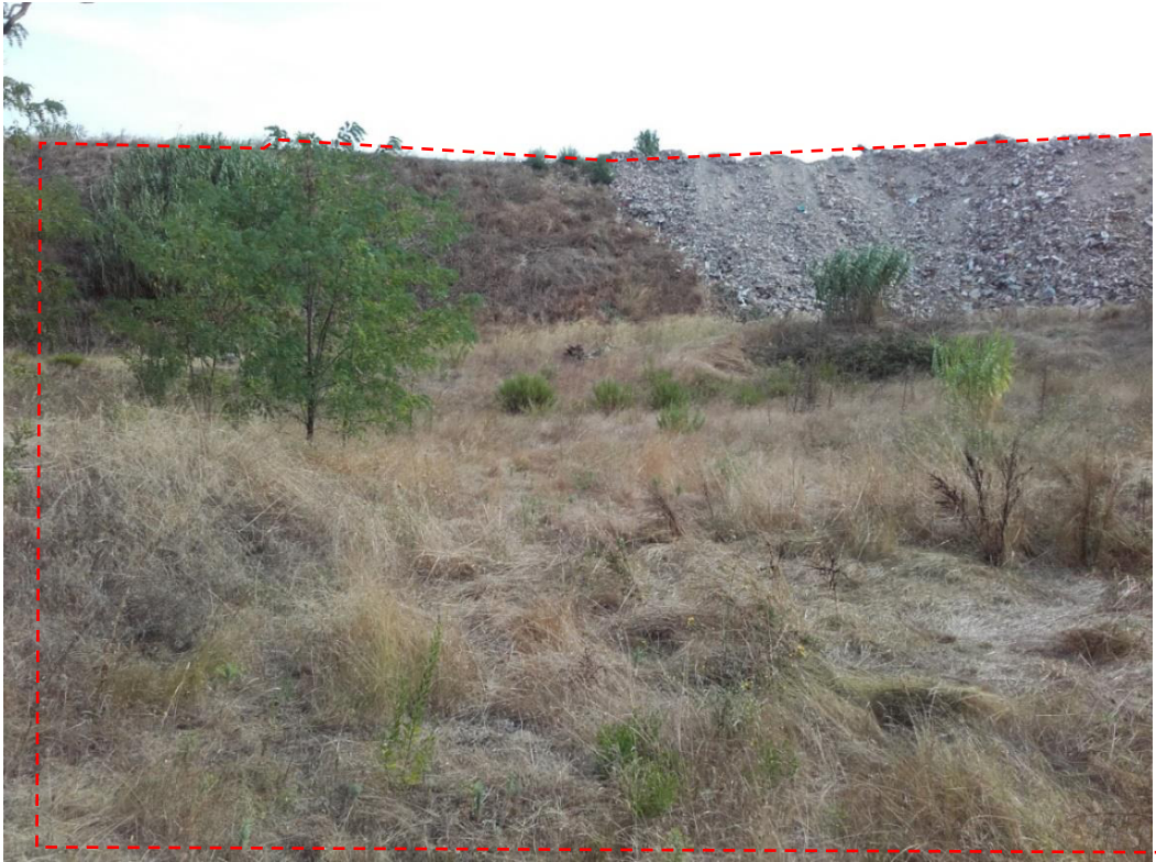
photographie 1 : état actuel du sol au droit du casier n°2 (en fond le talus du casier n°1 servant appui au casier n°2)
